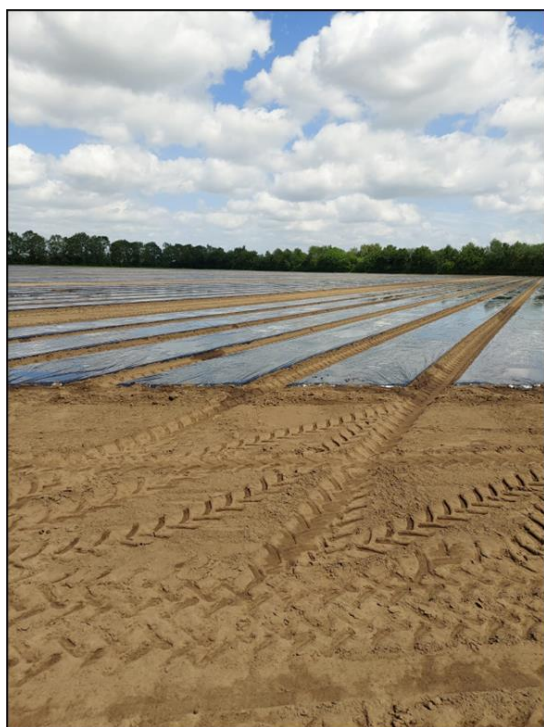
Afbeelding 13: Noodtrayveld in aanleg
