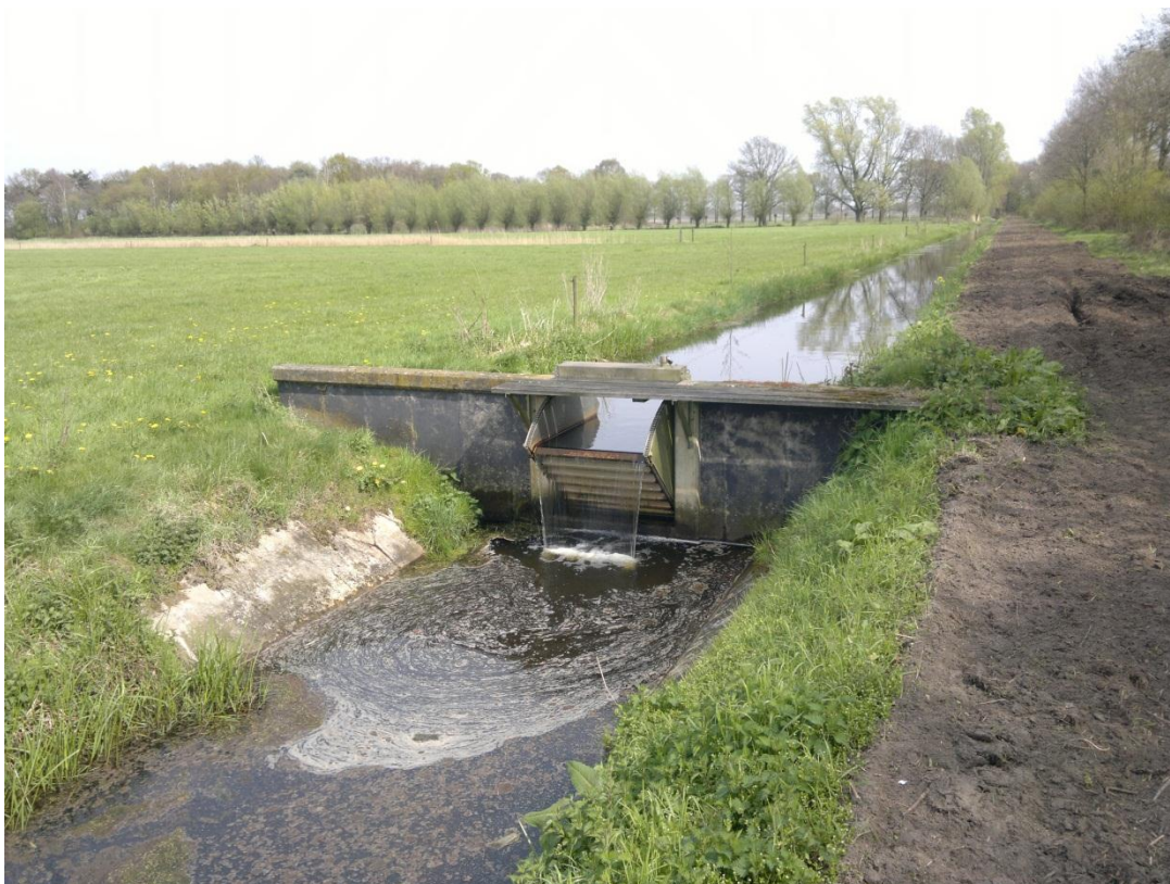
Figuur 2: Stuw in betonnen constructie
