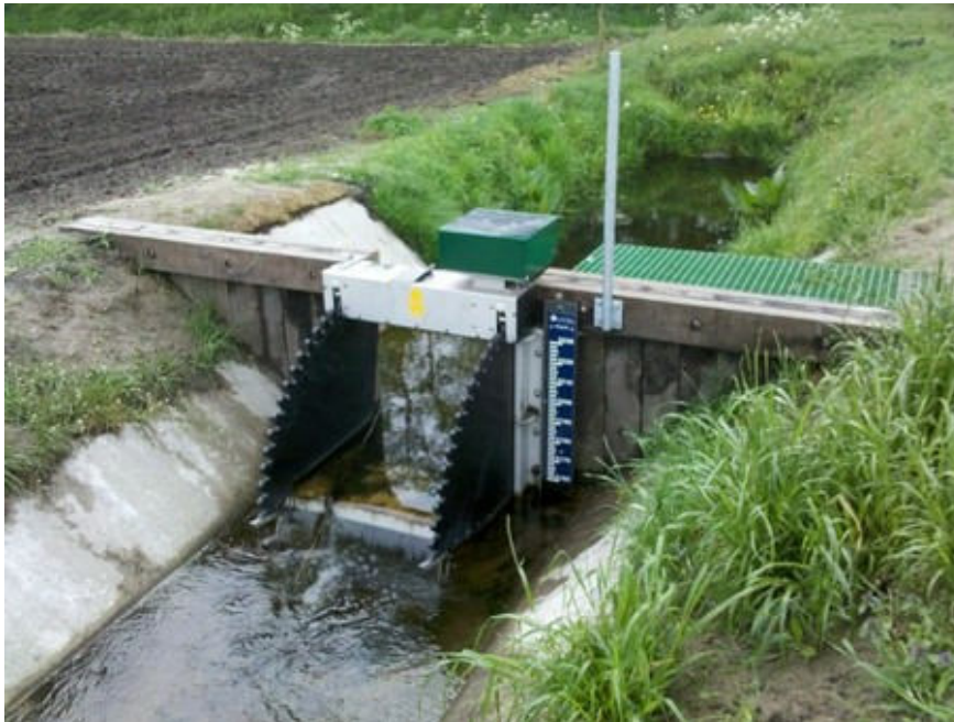
Figuur 6.1 voorbeeld van een te plaatsen kantelstuw
