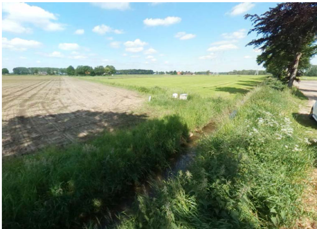
Figuur 3.2 Locatie geplande nieuwe stuw in de Liesloop met de relatief lage gronden aan de westkant van de geplande locatie. Om deze reden wordt de nieuwe kantelstuw iets meer stroomopwaarts geplaatst.
