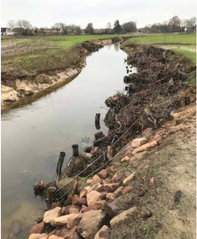
Stobben langs de Dinkel met verankering van houten palen en staaldraad (foto Esther de Jong).
