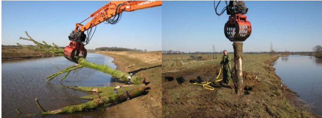
Plaatsen van een boom met mobiele kraan (links) en plaatsen van een ankerstam met spuitlans en kraan (rechts) [18].
