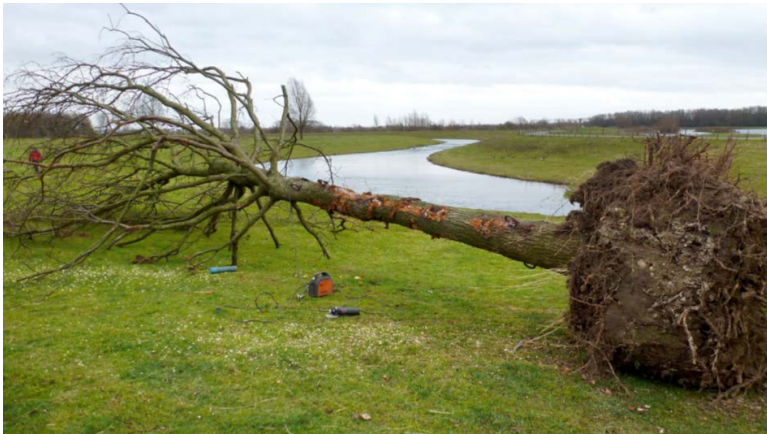
De boom met kruit, stam en takken wordt geplaatst met de kruin in stroomafwaartse richting [19].
