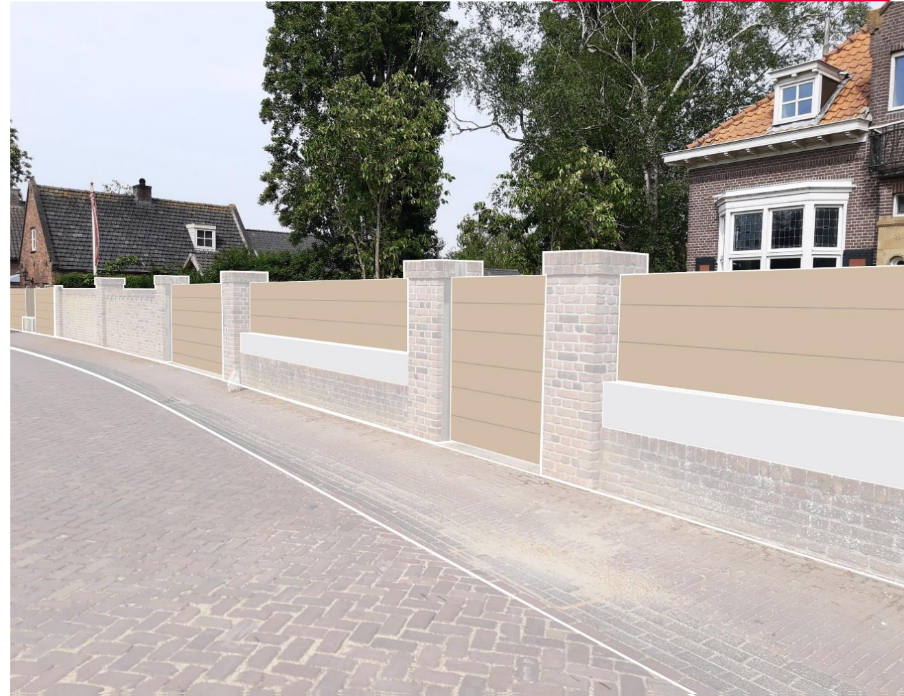
Hoogwatersituatie – kering opgebouwd
