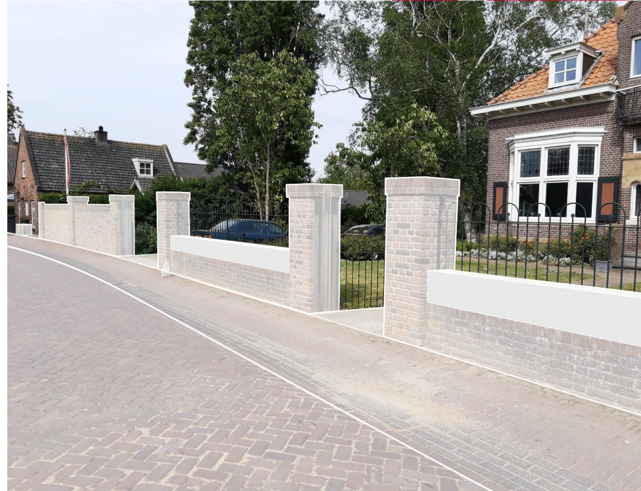
Dagelijkse situatie – kering niet opgebouwd
