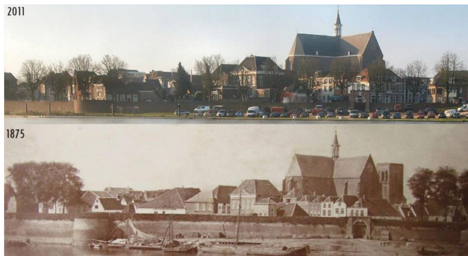
Figuur 69: de historische hoge vestingmuur en de huidige lage vestingmuur (Bron: Schetsboek Waterveiligheid Grave).
