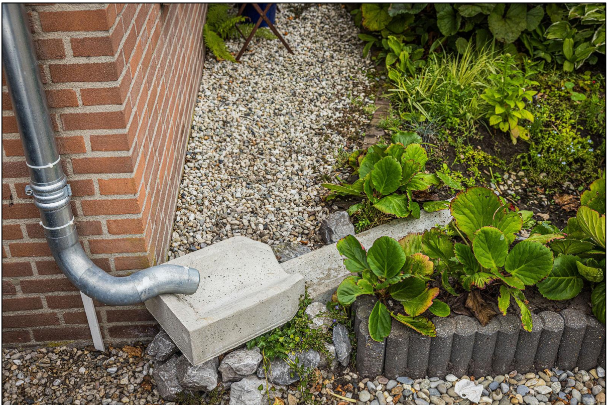
Afbeelding 7. Afkoppeling hemelwater
