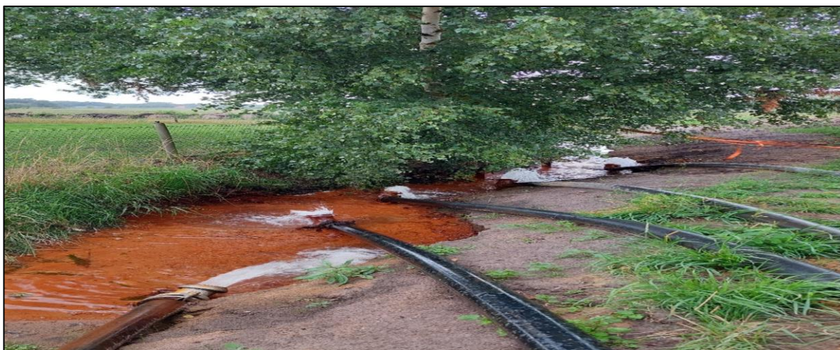
Afbeelding 9: Lozing ijzerrijk water vanuit een bronnering
