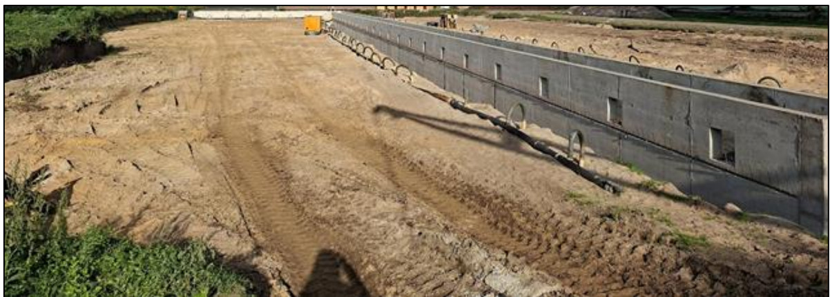
Afbeelding 13: Bronnering bij bouwactiviteiten
