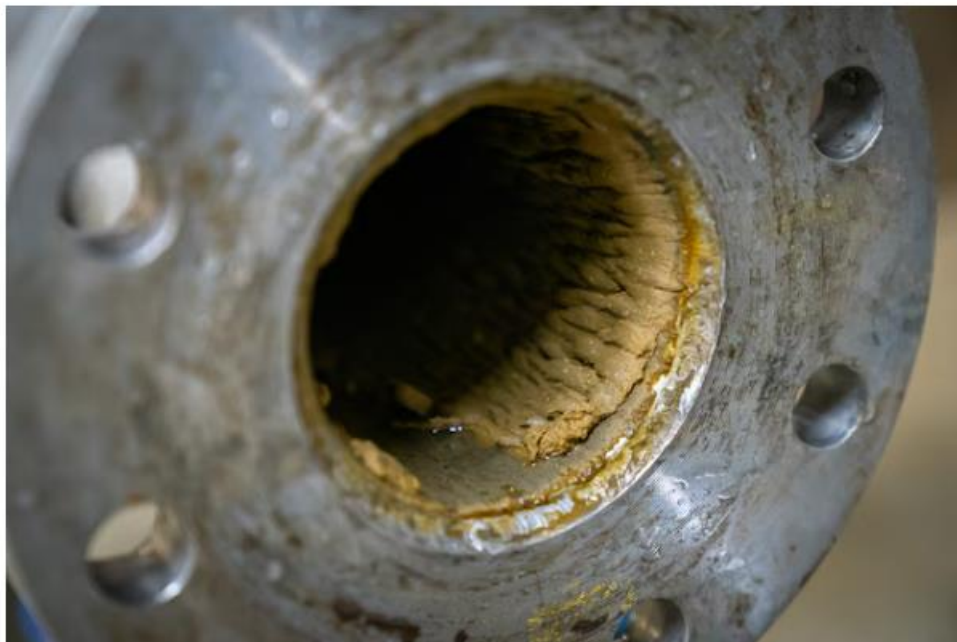
De vetlaag is in deze leiding goed te zien. Beeld Maikel Samuels
