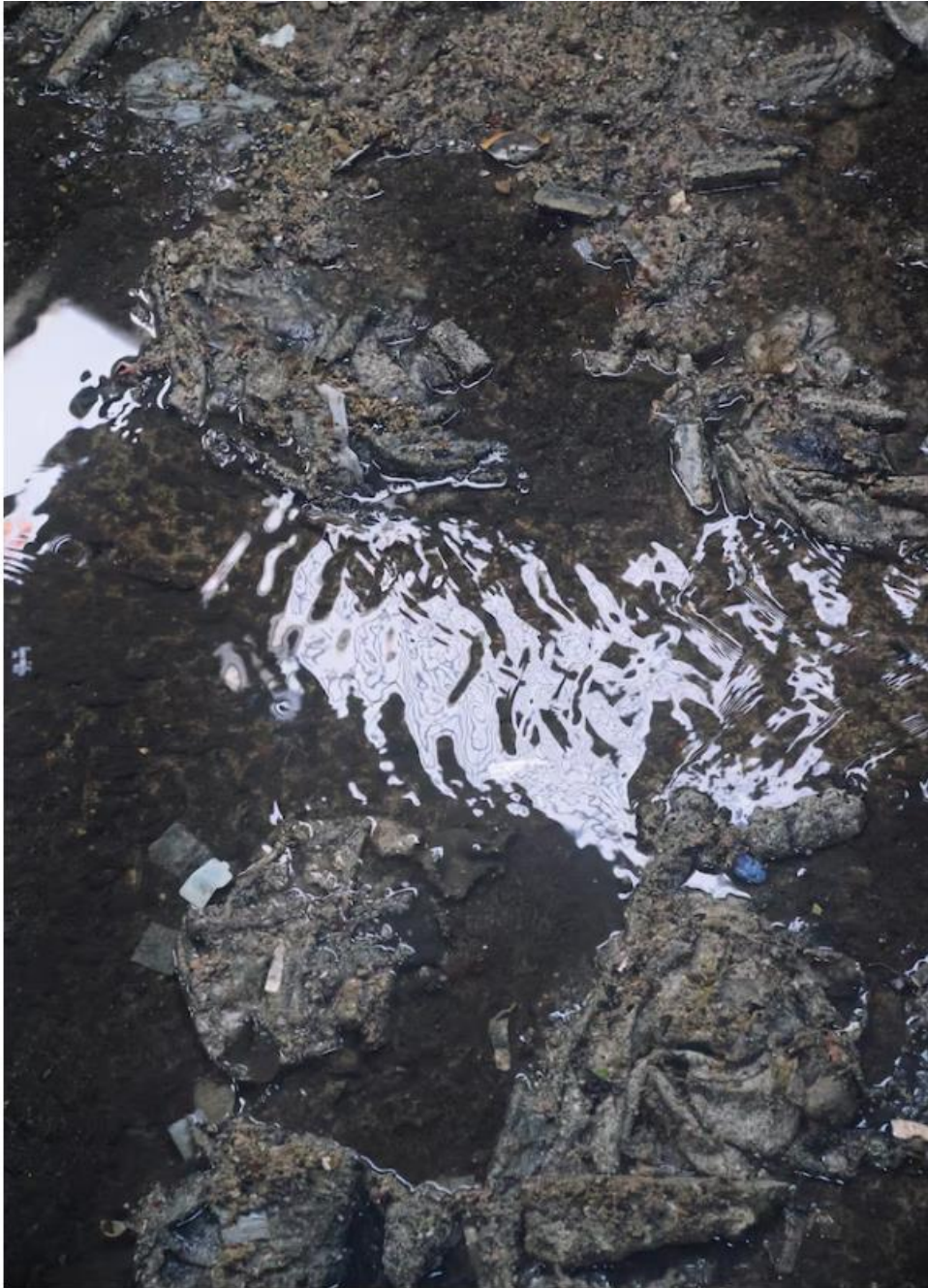
De put waarin het vet wordt opgeslagen dat in de bezinktanks uit het water wordt gehaald. Het vet bindt daarbij ook aan vochtige doekjes en andere ongewenste materialen die in het riool belanden. Beeld Maikel Samuels
