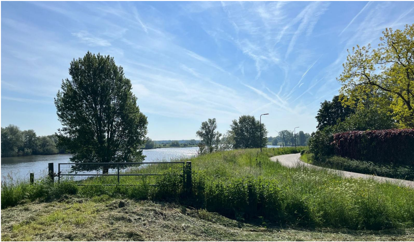
De tuimelkade langs de dijk.
