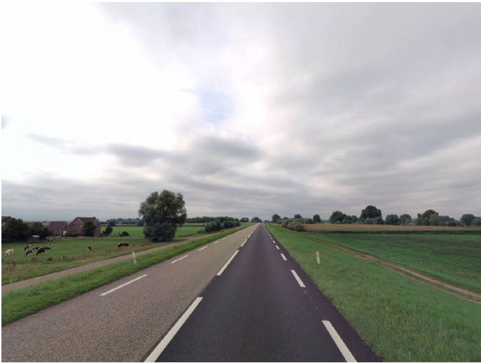
Wildse dijk, aangelegd bij de normalistaie van de Maas
