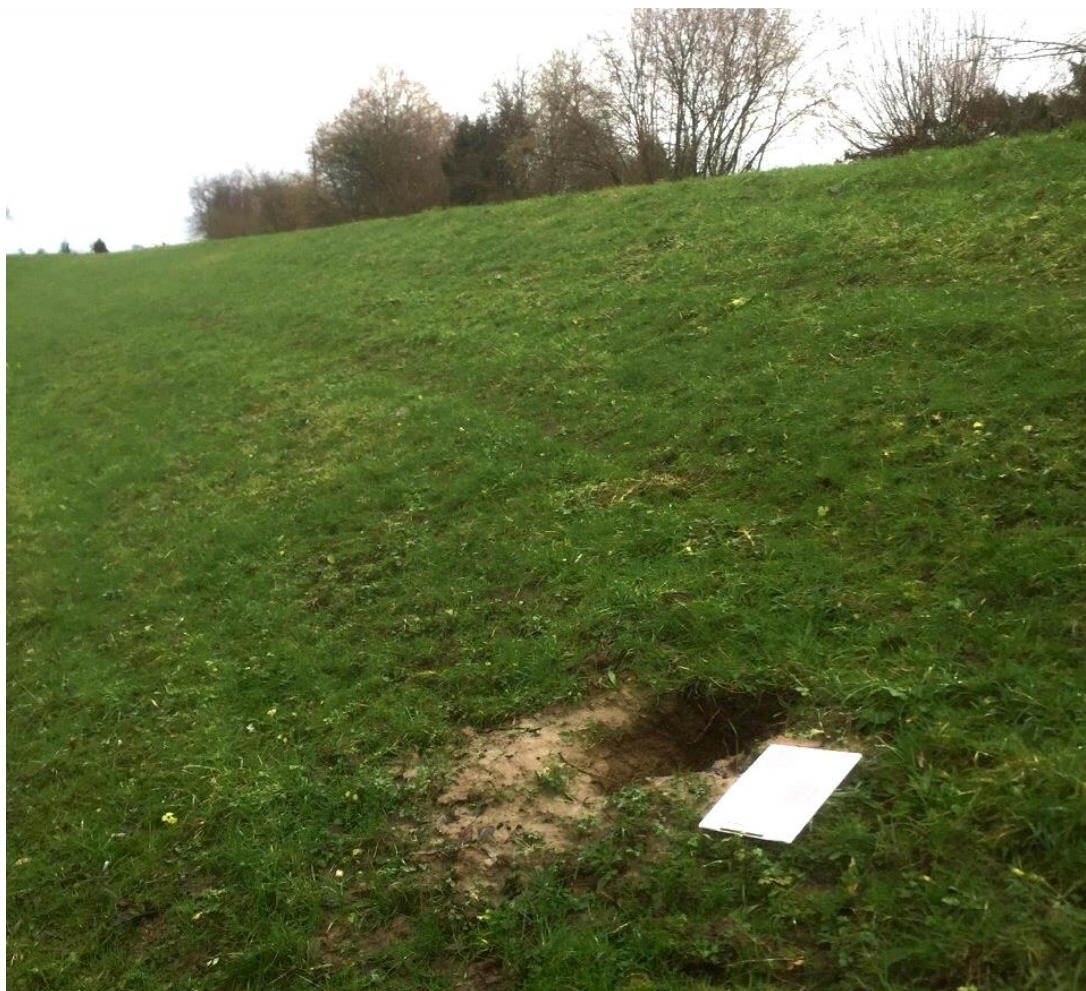
Figuur 15. Voorbeeld ondiepe dassenpijp in waterkering.
