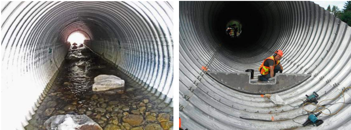
Figuur 8.2. Voorbeelden van inpassing van overlaten in de duiker (rechts) en stoorstenen met stenen bedding in duiker (links).
