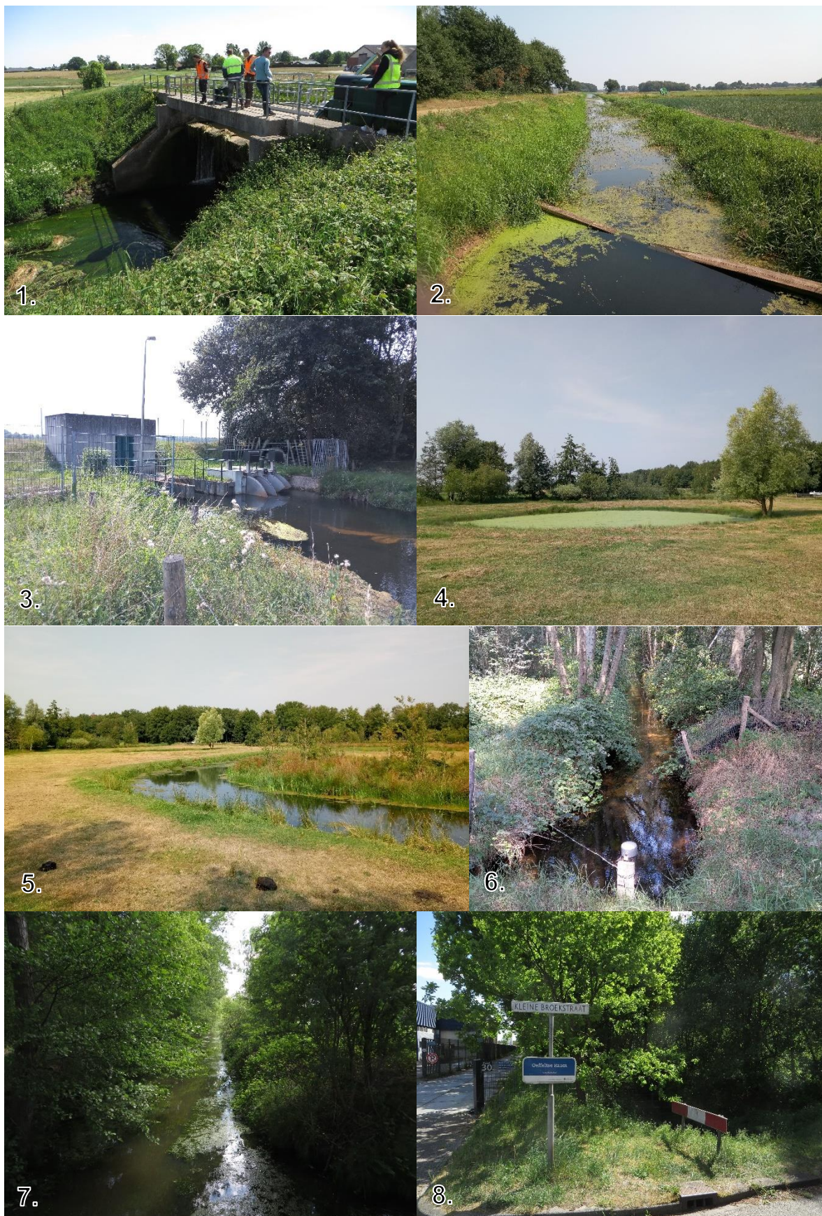
Figuur 2. Van boven naar onder: 1. Sambeekse uitwatering (stuw Waranda); 2. Sambeekse Uitwatering bovenstrooms gemaal Sambeek; 3. Gemaal Sambeek vanuit de Oeffeltse Raam gezien; 4. Heringericht deel Oeffeltse Raam (tussen Gemaal Sambeek en Sambeeksedijk); 5. Idem; 6. Bosloop benedenstrooms van Sambeeksedijk; 7. Idem; 8. Oeffeltse Raam vanuit de Kleine Broekstraat langs Saxe Gotha.
