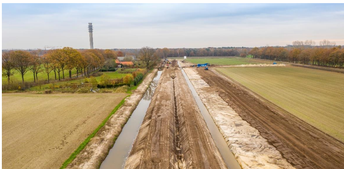
Afbeelding: werkzaamheden EVZ met landweer bij Tereyken (27 november 2020)
