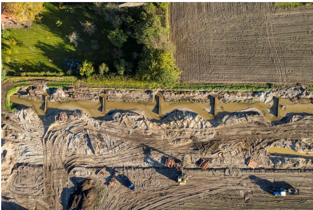
Werkzaamheden aanleg cascade bij Tereyken
