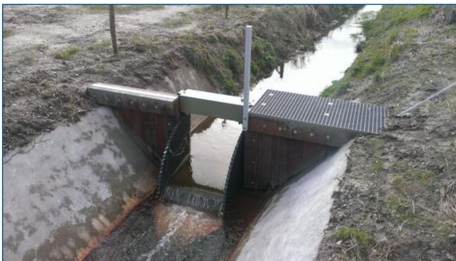
Figuur 1-11 Voorbeeld van kantelstuw
