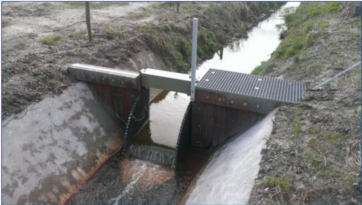
Figuur 1-6 Voorbeeld van kantelstuw
