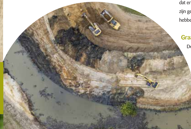
<< Werkzaamheden bij Middelrode
