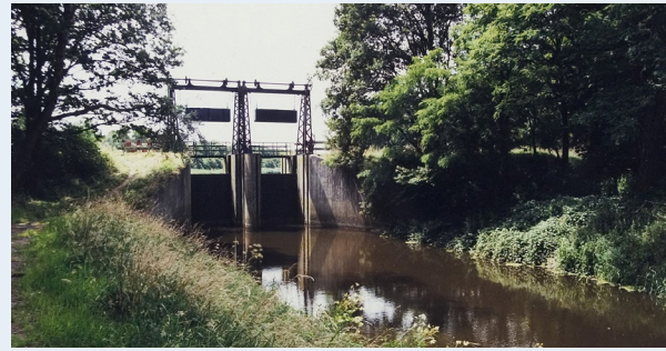
39 Bestaand sluisje aan het Drongelens Kanaal (fietspad) tegenover De Leij
