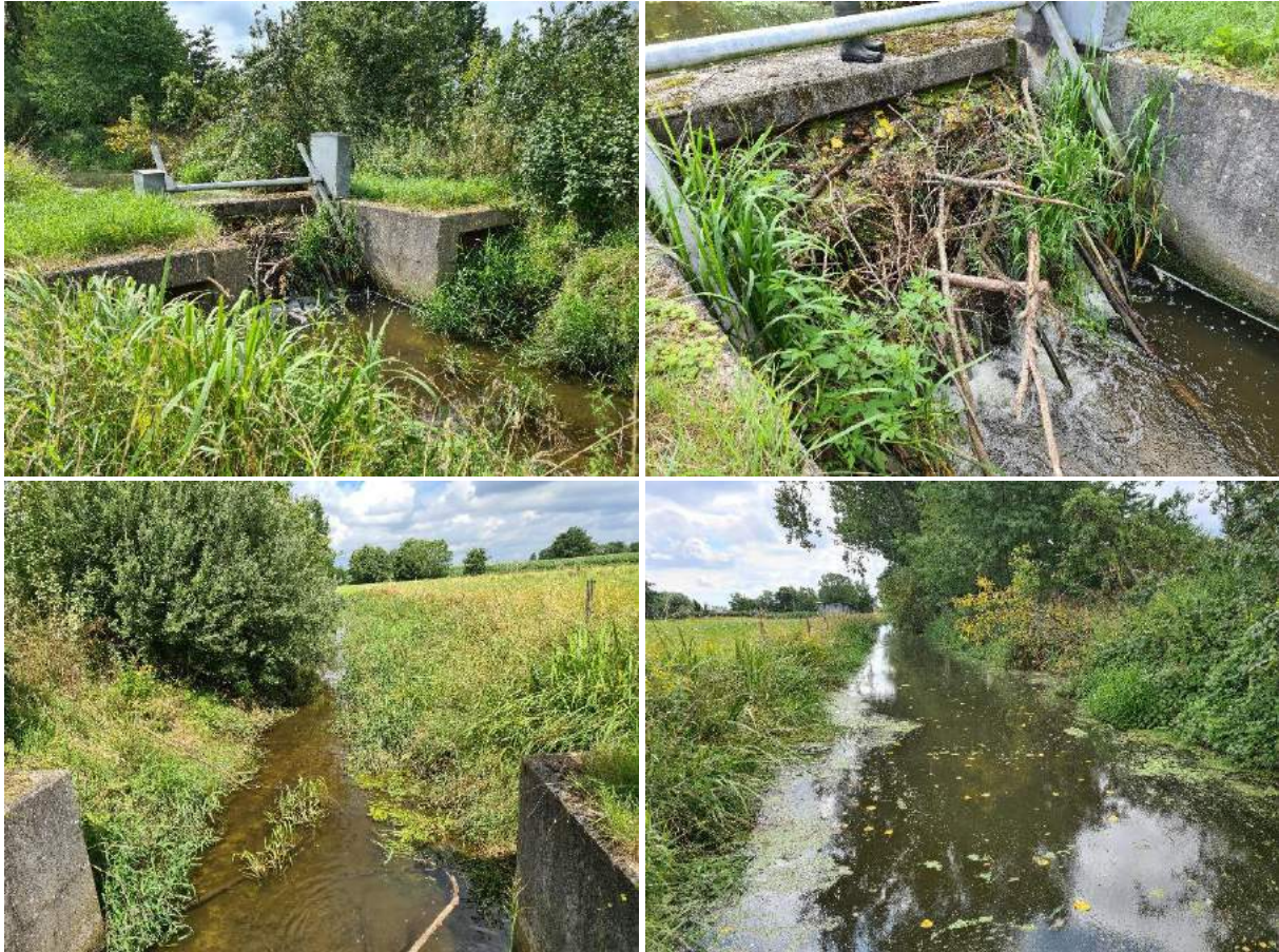
Figuur 7.1 Foto linksboven, stuw112ERS. Foto rechtsboven, opstopping van de stuw met takken door de bever activiteit. Foto linksonder, benedenstroomse deel van de stuw. Foto rechtsonder, bovenstroomse deel van de stuw
