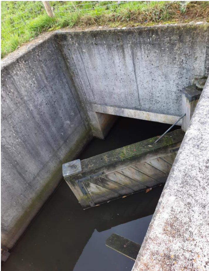
Figuur 3.2 Draaideur net benedenstrooms van de dijk iets verder op een kier (november van 2020)
