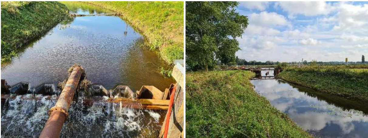
Figuur 2.1 Sambeekse uitwatering. Foto links, water stroomt over de damwand de Maas in. Pomp dient voor opmaling Maaswater tijdens droge perioden (water wordt richting Oeffeltse raam gepompt). Foto rechts, richting monding kijkend.
