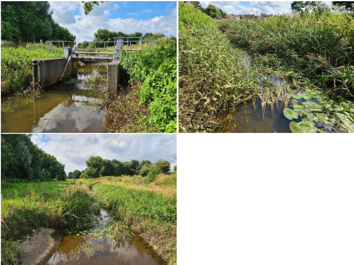
Figuur 6.1 Foto linksboven, stuw112ESS. Foto rechtsboven, benedenstroomse deel van de stuw. Foto linksonder, bovenstroomse deel van de stuw
