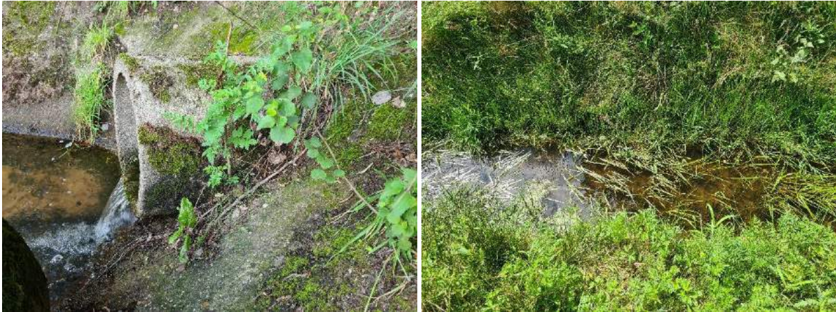
Figuur 11.1 Foto links, duiker met verval aan de benedenstrooms zijde. Foto rechts, loop van de Sint Jansbeek aan de bovenstroomse zijde
