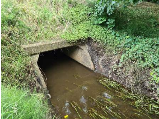
Figuur 4.1 overkluizing van de Sint Jansbeek onder de provinciale weg in Vortum-Mullem
