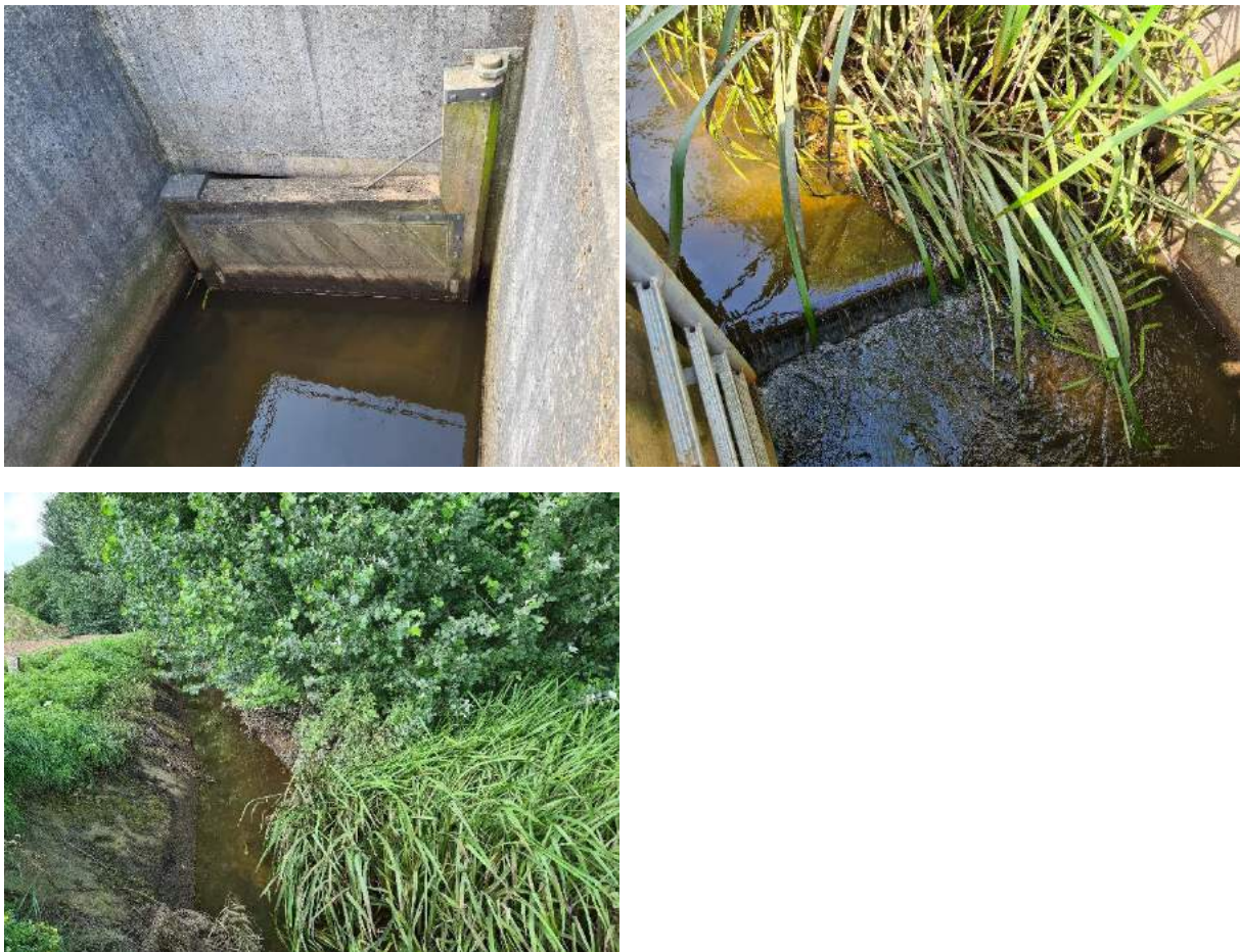
Figuur 3.1 Foto linksboven, draaideur net benedenstreams van de dijk. Foto rechtsboven, vaste houten overlaat. Foto linksonder, strakke inrichting aan de bovenstroomse zijde
