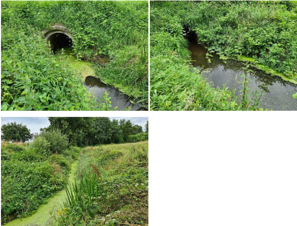
Figuur 8.1 Foto linksboven, betonnen duiker vanaf bovenstrooms gezien. Foto rechtsboven, betonnen duiker vanaf benedenstrooms gezien. Foto linksonder, benedenstroomse deel van de duiker.
