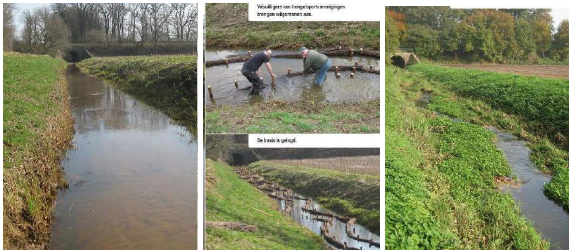
Figuur 12.1. Voorbeeld van versmallen zomerbed en micro-meandering. In Duitsland is hiermee ervaring op meerdere plaatsen.
